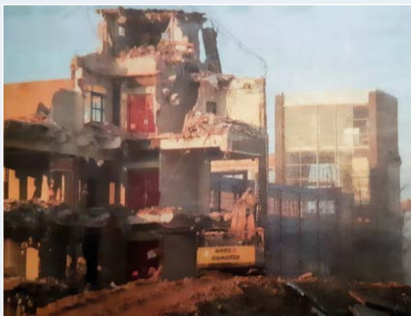
Sloopwerkzaamheden aan gebouw HD en HE.
