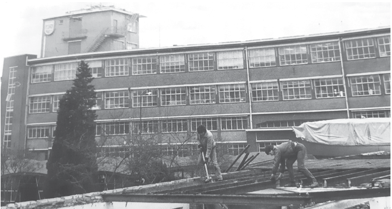
Gebouw HD, en sloopwerkzaamheden pand fa. Oortman, medio 1985
