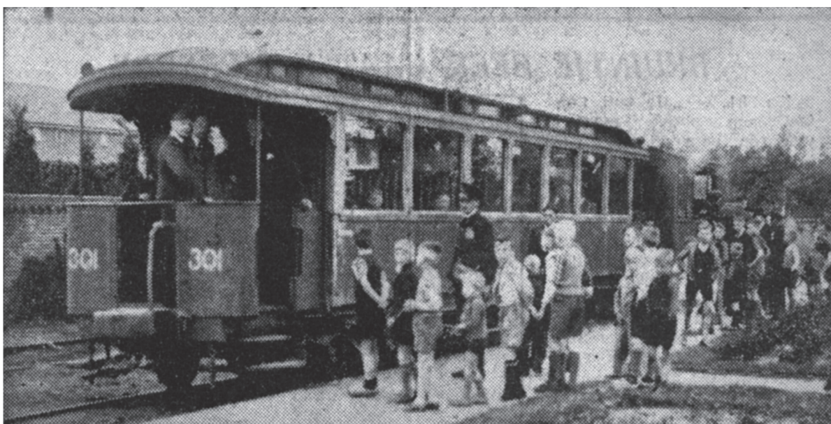
De indertijd opgebroken rails van de Gooische tram op de baanvakken Laren-Blaricum en Blaricum-Huizen zijn opnieuw gelegd en de verbinding tusschen deze plaatsen is tot groote tevredenheid van de inwoners hersteld. Mei 1942.
