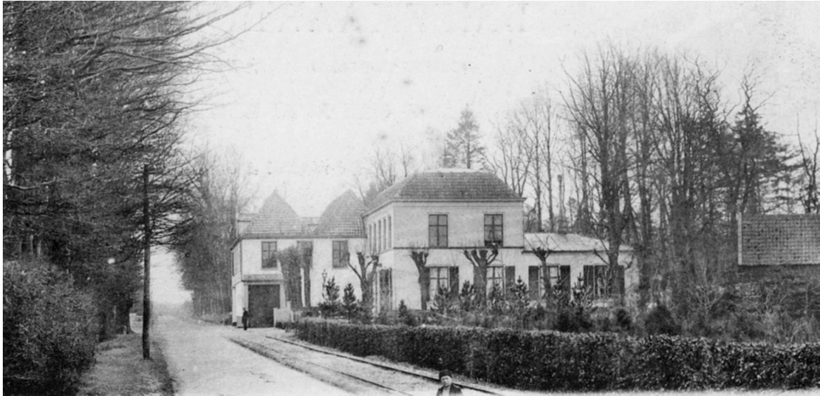
De straatweg Naarden-Amersfoort langs Jan Tabak omstreeks 1900. De weg had een totale lengte van 25½ km, was 4,13 m breed en in het wegdek waren bijna 15 miljoen klinkers verwerkt.
